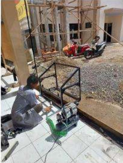
**Gambar 3. 7 Proses pengecatan rangka**
