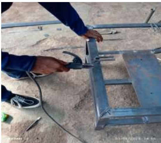
Gambar 4. 9 Pemasangan dudukan tapak kuda
