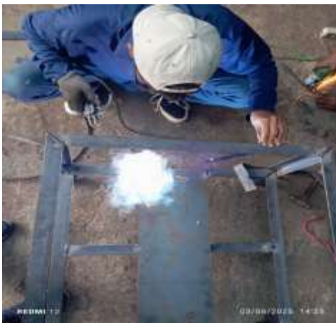
Gambar 4. 12 Pengelasan dudukan tungku pembakaran
