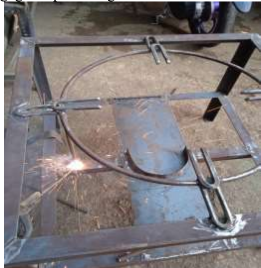
Gambar 4. 14 Proses pemasangan tiang penyangga dengan cara di las
