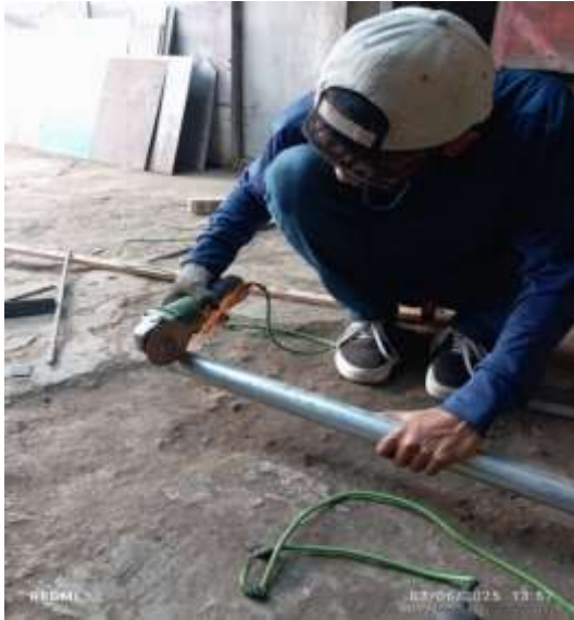
Gambar 4. 5 Pemotongan Pipa
