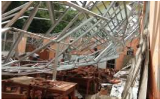
Gambar 1. Keruntuhan Rangka Atap
