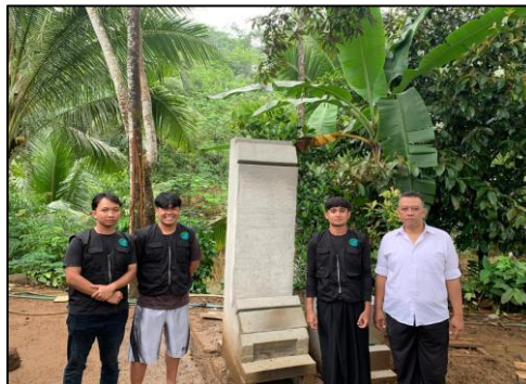
Gambar 2. Incinerator Sederhana minim asap yang telah selesai dibangun di Desa Tambaksari
