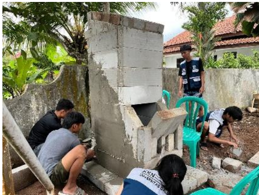
Gambar 1.1 Kegiatan pembuatan Rocket Stove
